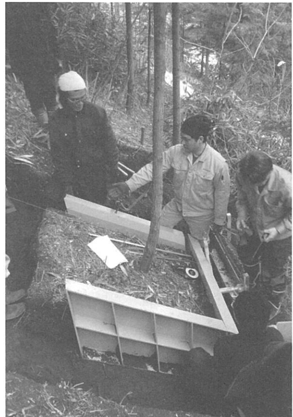
図-2. 樹木根系を含む大型直接せん断試験用の供試体の作成状況
