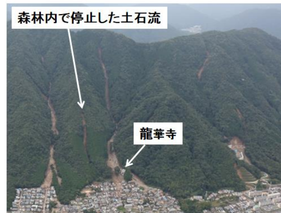
図一1. 平成 26 年 8 月豪雨で発生した広島市土砂災害の様子 (西を望む。龍華寺の南約 100m に位置する土石流は 300m 以上流下したものの森林内で運動が停止している) (平成 26 年国土地理院撮影の空中写真の一部に加筆)
